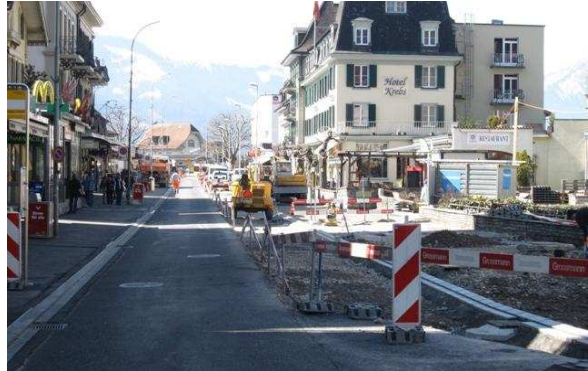
Aggloprogramm Verkehr + Siedlung Interlaken: Vorbereitungsarbeiten Bahnhofstrasse
