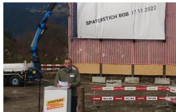
Peter Aeschmann am Spatenstich Park+Ride Matten.
