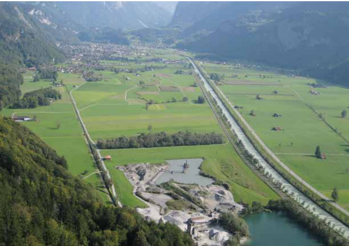
Talboden von Meiringen: intensiv genutzt, ungenügend vernetzt. Foto: Adolf Urweider
